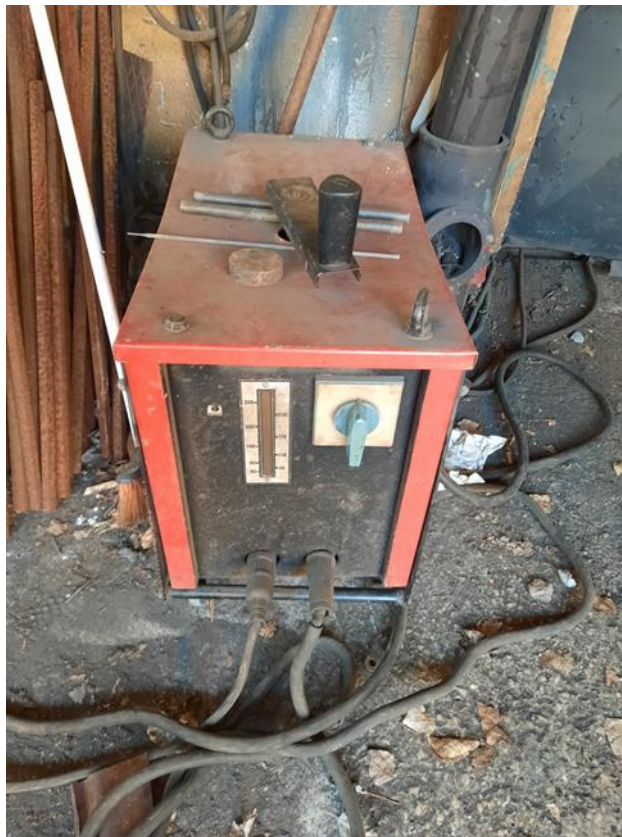
Slika 3 Fotodokumentacija postojećeg stanja
